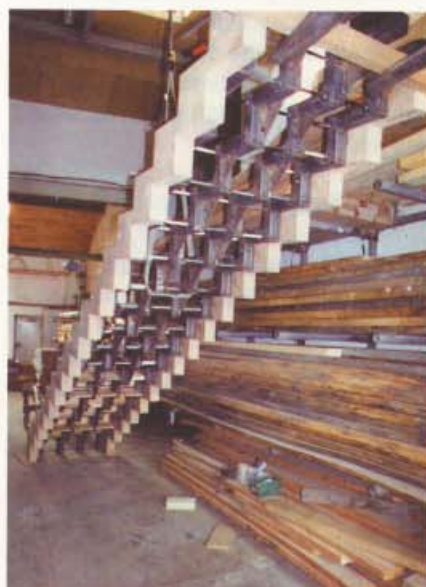
Bild 10: Treppenrückseite während der Herstellung
