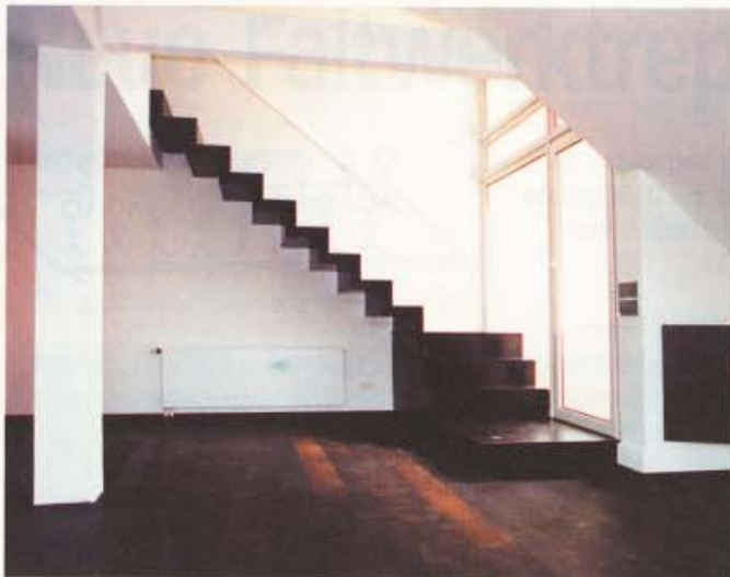
Bild 7: Aus einem Treppenblock heraus steigt eine zierliche Treppe empor. Der wandseitige Lichtspalt unterstützt den Eindruck von Leichtigkeit.
