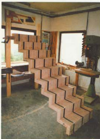
Bild 8: Da die Treppe nicht an der Wand befestigt werden durfte, wurde ein selbsttragendes Faltwerk aus Furnierschichtholz und Stahl entwickelt.
